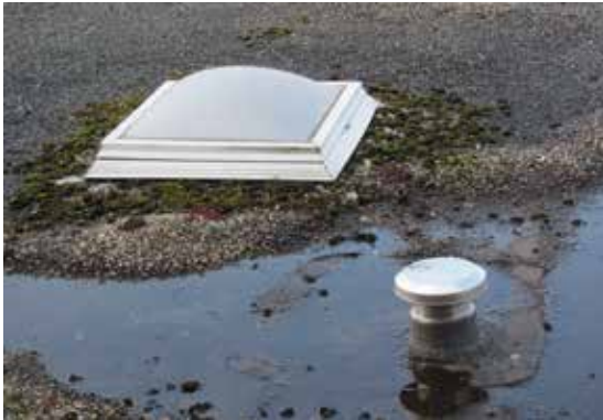
Sanierungsbedürftiges Flachdach
