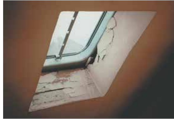
Undichtes Dachflächenfenster
