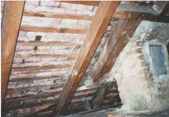
Ungedämmter Dachstuhl
